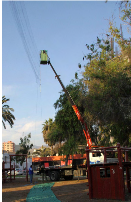
Instalación de Red de Niebla en Av. Brasil.
