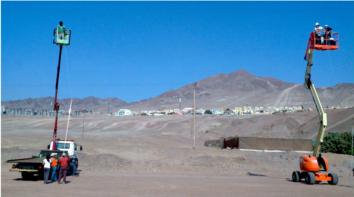
Entrenamiento, ensayo logístico e instalación Red de Niebla en altura.
