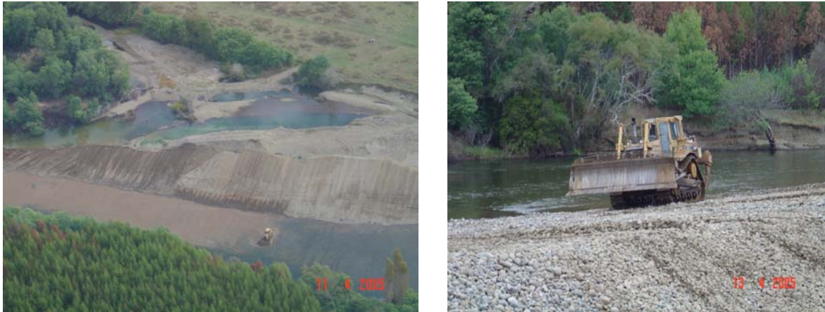
Fotografía 2. Movimiento de áridos en el cauce del río Cruces, aguas arriba de San José de la Mariquina. A la izquierda se observa la pluma de dispersión de color marrón que se desplaza por el río Cruces, producto de la actividad de excavación del buldózer sobre el fondo del río.
